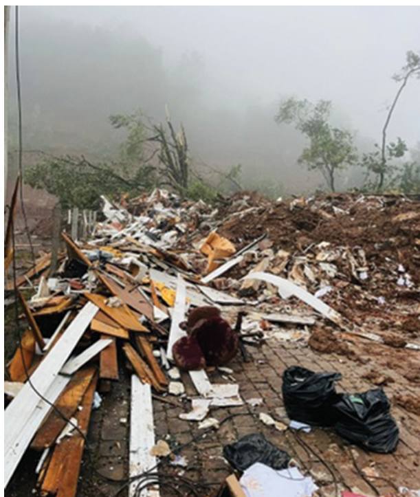
Cartório de Galópolis, em Caxias do Sul, teve sede destruída por um deslizamento de terra
